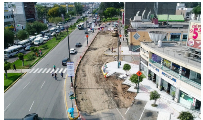
Rehabilitación Tramo Av. La Molina - Av. La Fontana
